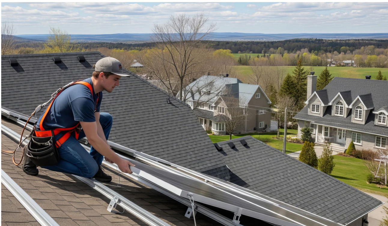
Installateur à l'œuvre : Crédit ESQ
