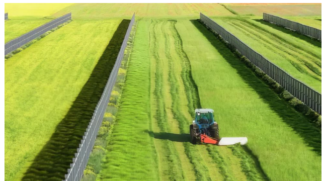
Panneaux verticaux est-ouest : Crédit Engie-Green
