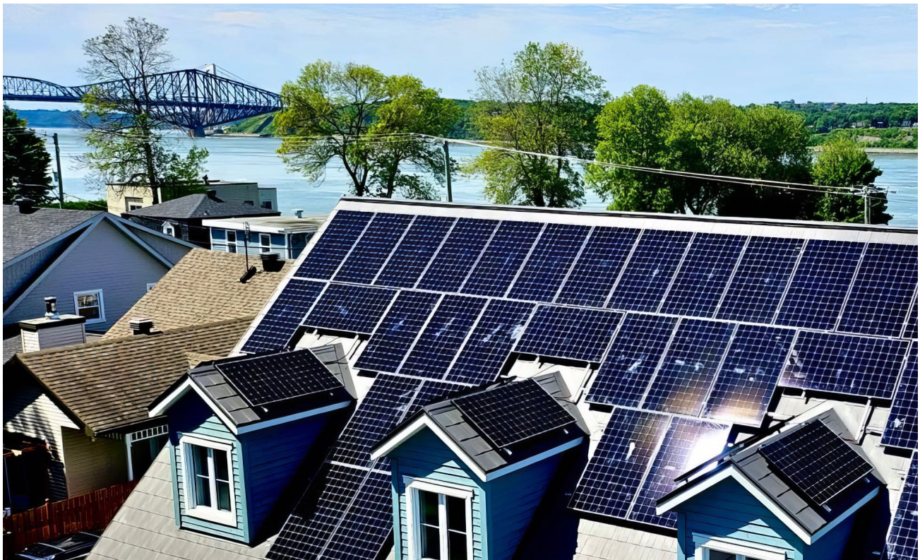
Toit solaire : Crédit Maxime Morency
